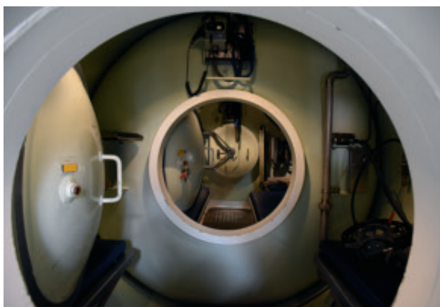
Figur 9. Tryk-tanken (øverst), dens kontrolpanel (midten) og et kik ind gennem slusen til selve trykkammeret (nederst). Dykkerskolen på Holmen. (Foto: Ole Sonne)
