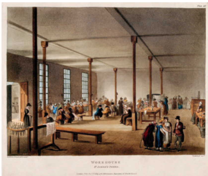
Figur 3. Interiør fra arbejds huset i Poland Street, Soho i London. Københavns Fattigvæsen havde omkring 1800 i hvert af byens sogne et arbejds hus med tilhørende skole for de fattiges børn. Arbejds huset var et sted, hvor de fattige boede og måtte arbejde for den fattighjælp, de modtog. Farveakvarel af T. Sunderland efter A.C. Pugin og T. Rowlandson, 1809. (Wellcome Library, London, V0013836)
