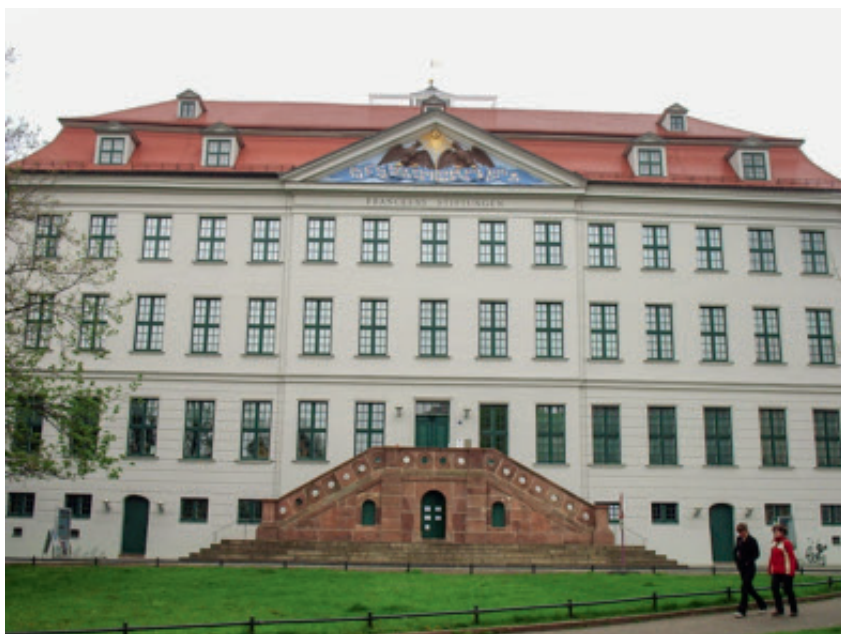
Figur 4. Hovedbygningen i den Francke'ske stiftelse i Halle. Bygget omkring 1700. Bag denne ligger et stort bygningskompleks opført i bindingsværk samtidigt med hovedbygningen. (Foto: Sven Erik Hansen, 2009)
